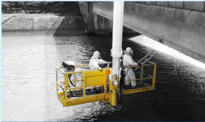
Réparation EU en nacelle
