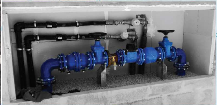
Montage compteur DN 100 - CEYRESTE
