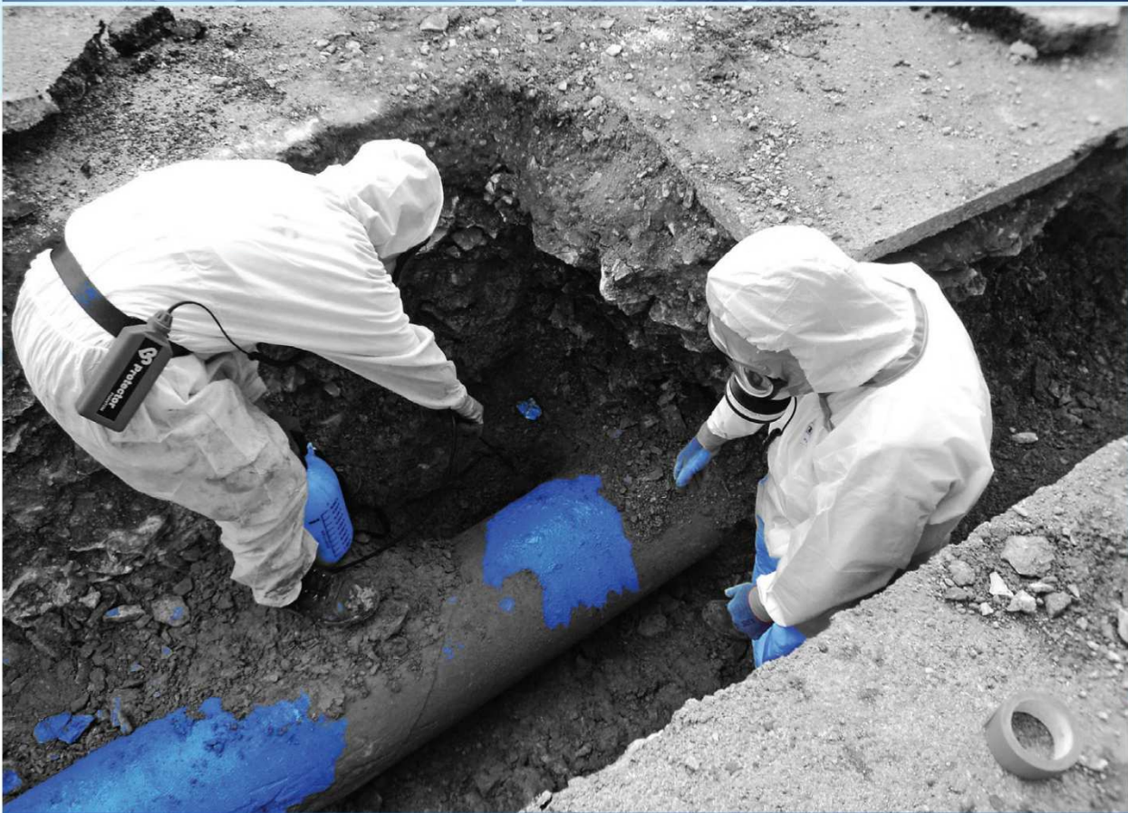
Réparation fuite sur conduite amiante ciment - MARGNANE
